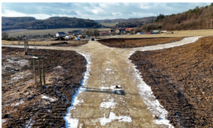
Probíhající zemní práce – podzim a zima 2023.
